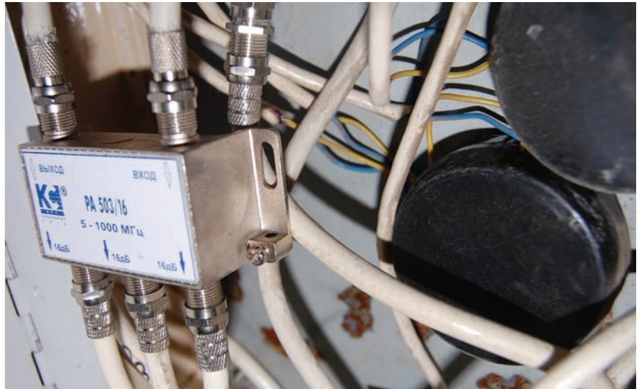
Фильтр, применяемый в «СКТВ» для выделения пакетов каналов
