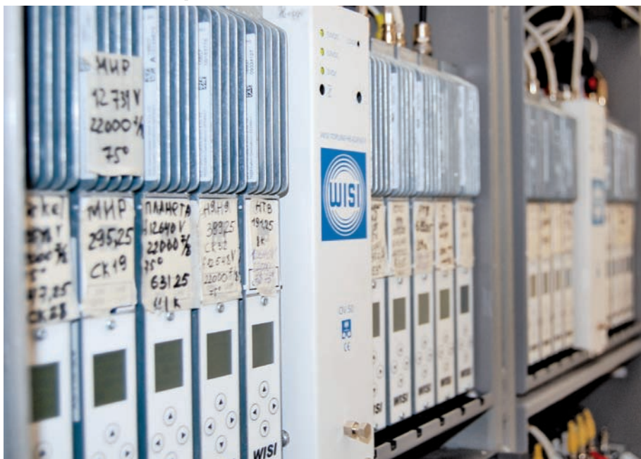
Головная станция «СКТВ» производства WISI
